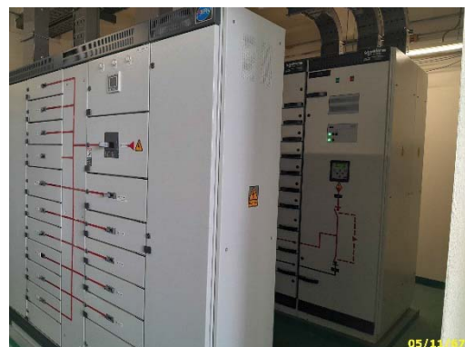
ระบบไฟฟ้าโครงการส่วนขยาย (MDB) อาคาร E
